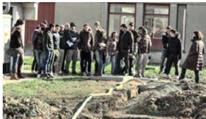
Visite degli studenti durante i lavori di realizzazione dell'impianto geotermico
