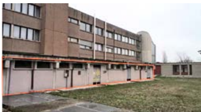
Ubicazione della centrale termica del complesso scolastico di Codigoro
